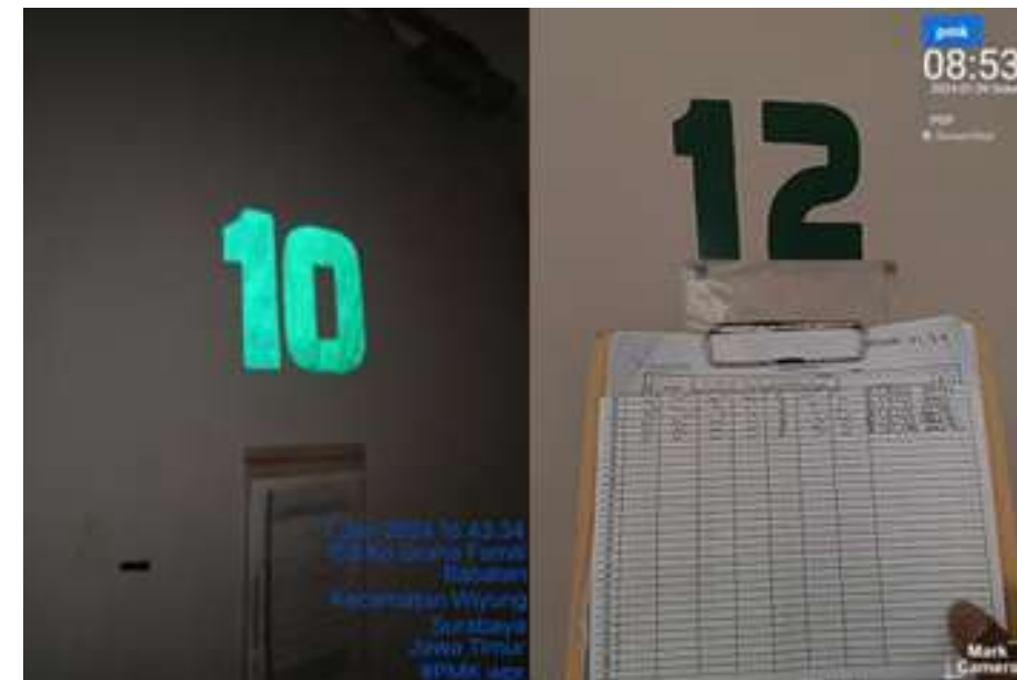
Pemeriksaan rutin seluruh tangga darurat & sprinkler
