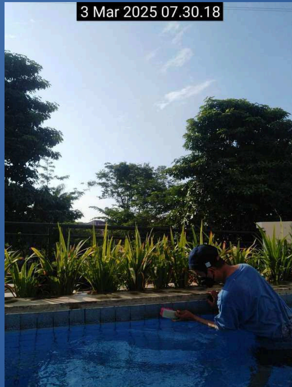
Pembersihan kerak dinding pool
