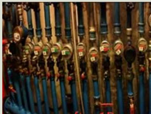
Guna menjaga distribusi air ke seluruh unit tetap terjaga dengan baik , maka kami mengadakan program penggantian header pipa air bersih di seluruh tower. s/d bulan Desember 2023 telah selesai untuk tower A-B-C
