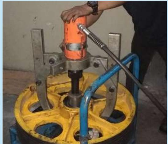
**Penggantian Wire Rope Lift dan Bearing Pulley CWT**
